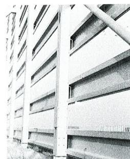
L'optimisation du « système » de plusieurs écrans poreux résulte d'une combinaison entre les taux de perméabilité, leur évolution d'un écran à l'autre et les espacements correspondants.
