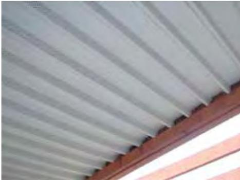
Exemple d'aspect de profils nervurés HACIERCO perforés en âme
