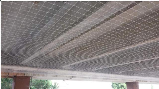
Fils anti pigeon sur structure metallique
