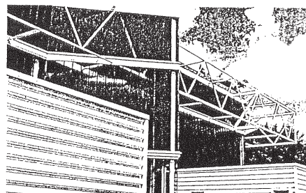
Membrures en profils IPE ou HE boulonnés sur gousset soudé.
